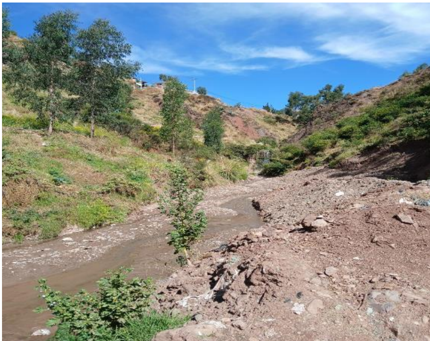
FOTOGRAFIA N° 01: TRAMO CRÍTICO EN EL CAUCE DE LA QDA. , SE APRECIA LA EROSION DE LOS TALUDES DE RIVERAS Y LA COLMATACION DEL CAUCE NATURAL
